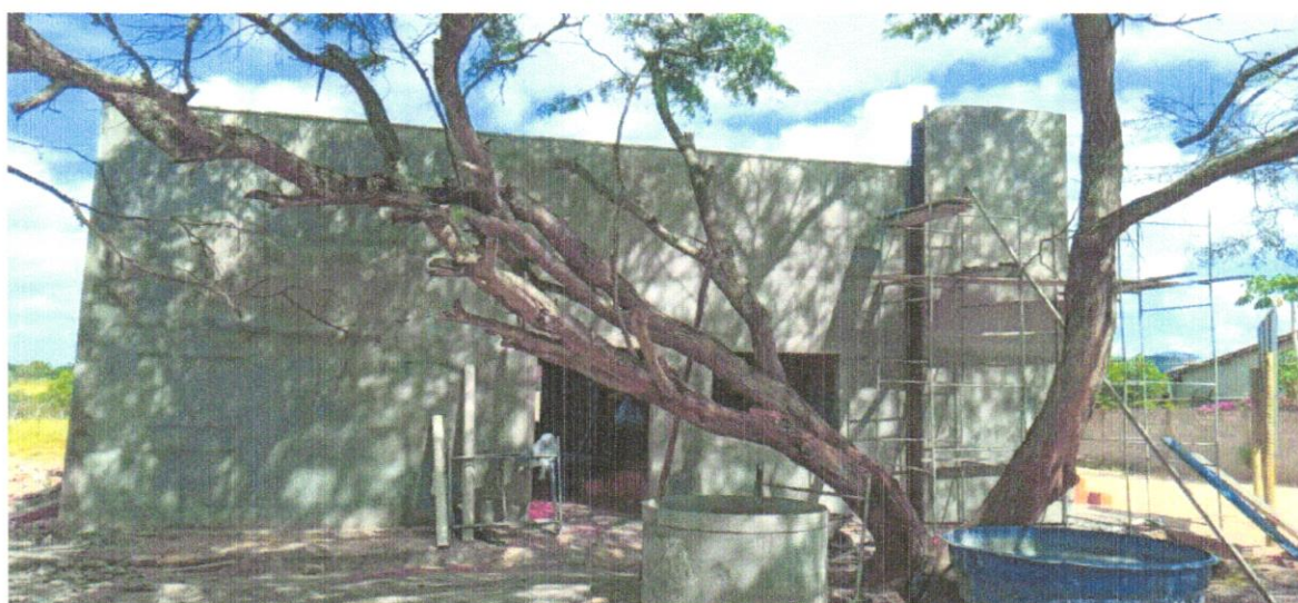
FOTO 01 – CHAPISCO APLICADO EM ALVENARIA (COM PRESENÇA DE VÃOS) E ESTRUTURAS DE CONCRETO DE FACHADA, COM EQUIPAMENTO DE PROJEÇÃO. ARGAMASSA TRAÇO 1:3 COM PREPARO EM BETONEIRA 400 L. AF_06/2014
