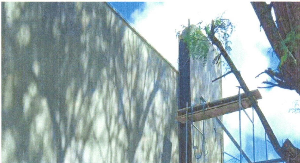
FOTO 11 - Chapim de concreto pré-moldado
